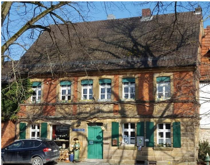
Abbildung 49: Erdgeschoss aus Sandstein, Obergeschoss aus Ziegelmauerwerk
