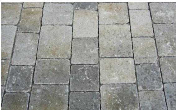
Abbildung 28: Fugenreduziertes Betonpflaster
