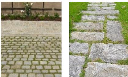
Abbildungen 89, 90: Pflaster / Platten mit breiten begrünten Fugen
