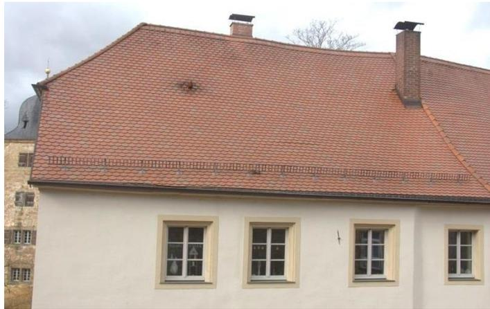
Abbildung 77: Biberschwanzdeckung auf einem Gebäude in Thurnau
