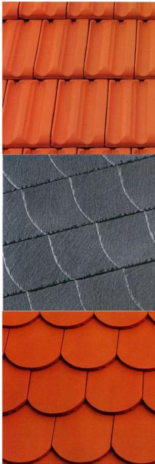
Abbildung 71: Falz-, Schiefer- und Biberschwanzdeckung im Detail
